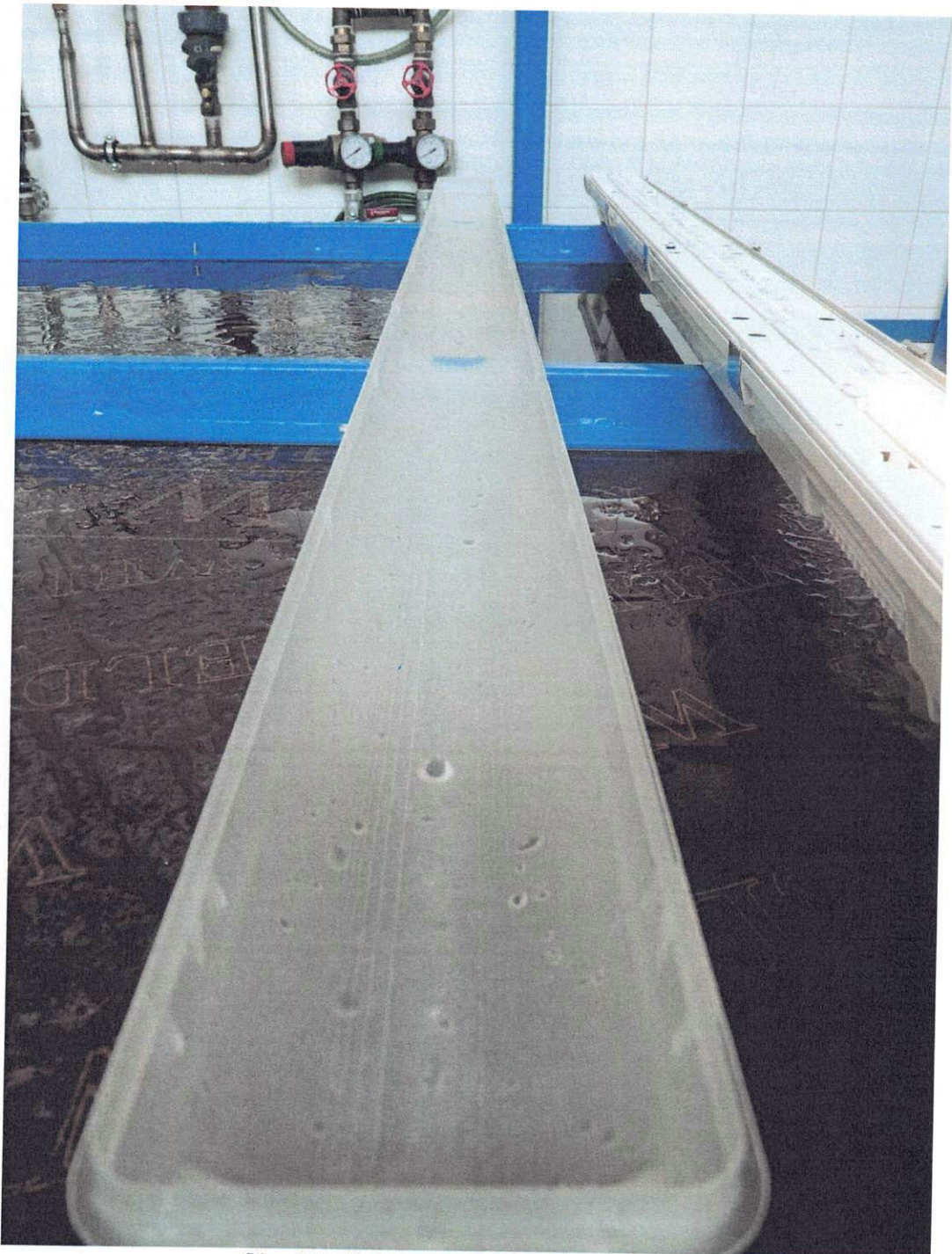
Obr. 5 Vnitřní strana difuzoru po zkouškách
